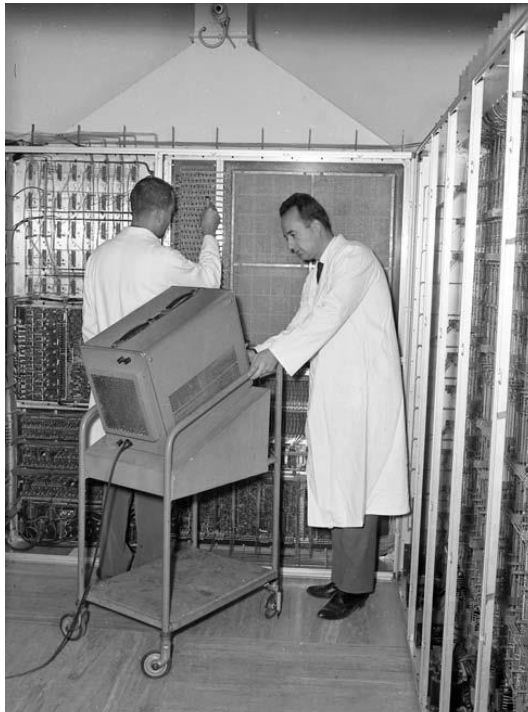
Luigi Pistelli, davanti all'oscilloscopio, al collaudo della CEP (Calcolatrice Elettronica Pisana), 1960
