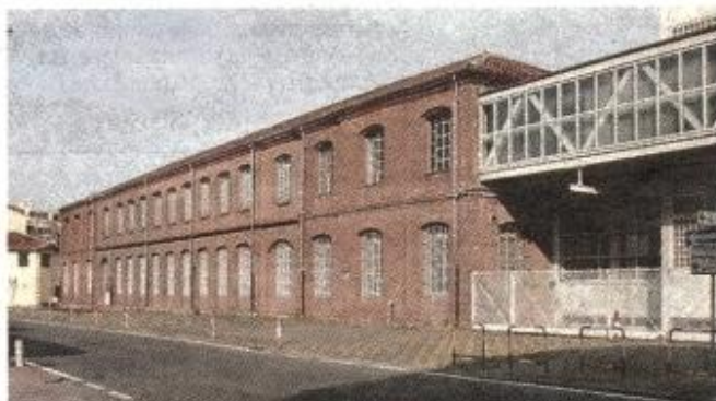
La prima fabbrica Olivetti, quella in mattoni rossi
